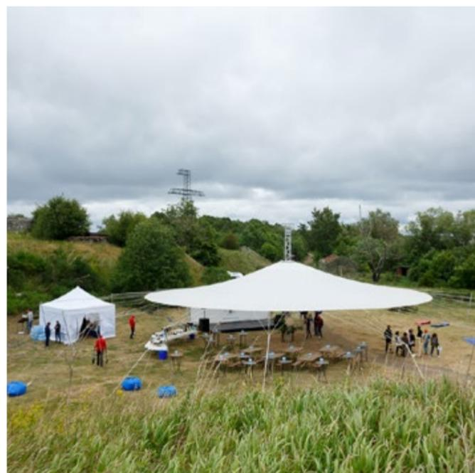
Тентовая система опирается на центральную опору и закрепляется по периметру с помощью растяжек, распорок, кольев или балласта. Преимущества этого варианта заключаются в малом весе конструкции, простоте транспортировки и в возможности установки без привлечения спецтехники, такой как кран или вилочный погрузчик. К тому же, конструкция Magic Sky Tower выглядит эффектно и элегантно.
